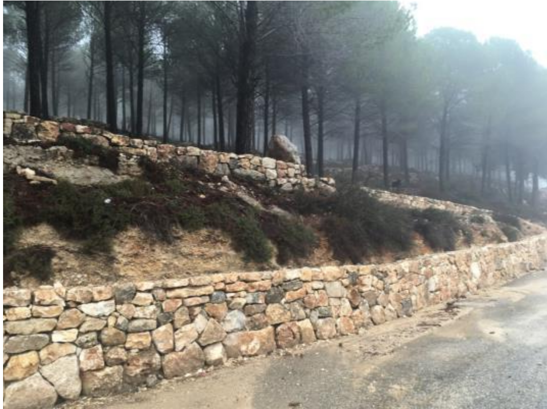
صورة رقم (41): ترميم السلاسل الحجرية لمنع انجراف التربة. خلال الزيارة الميدانية إلى متنزه صطاف، بتاريخ 2 كانون الثاني 2018.
